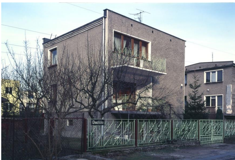
Dom przed termomodernizacją
