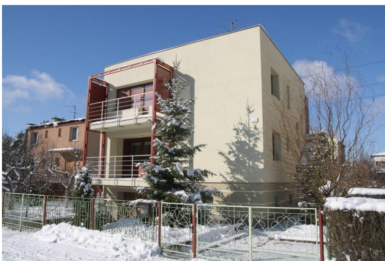
Dom po termomodernizacji
